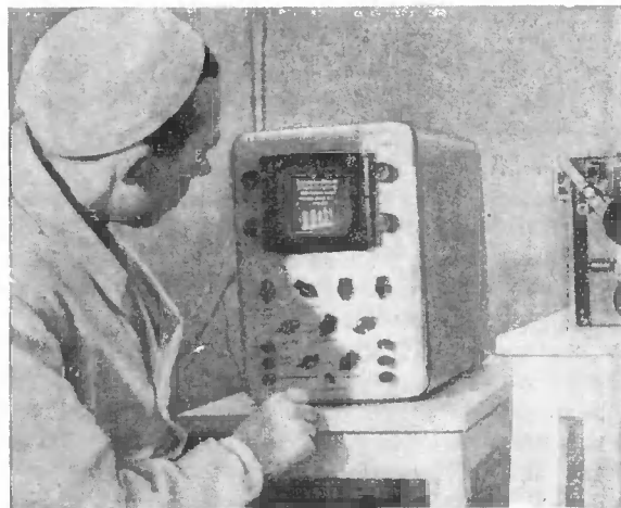
Рис. 4. Исследователь у экрана электроэнцефалоскопа Ливанова-Ананьева. На экране сверху — пространственная картина биопотенциалов в виде 50 точек; внизу — амплитудное значение каждой точки
